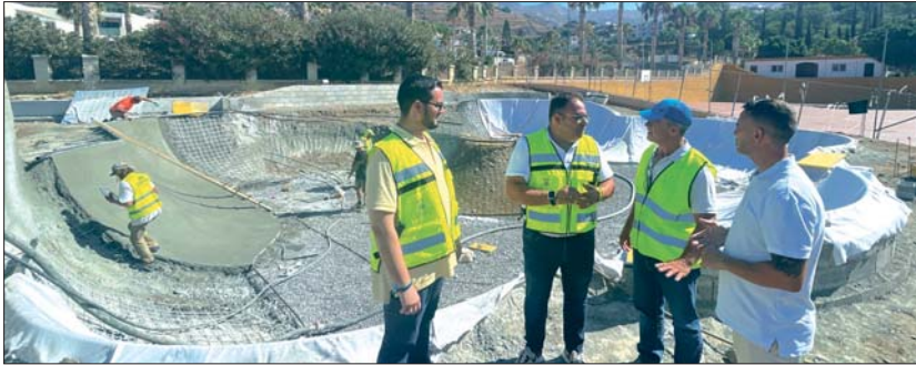
Juanjo Ruiz Joya, junto a los concejales de Deportes y Obras, Luis Aragón y Francisco Rodríguez, y el arquitecto técnico.FC
